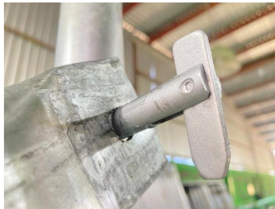
CONEXIÓN DE CRUCETAS DEL ANDAMIO
